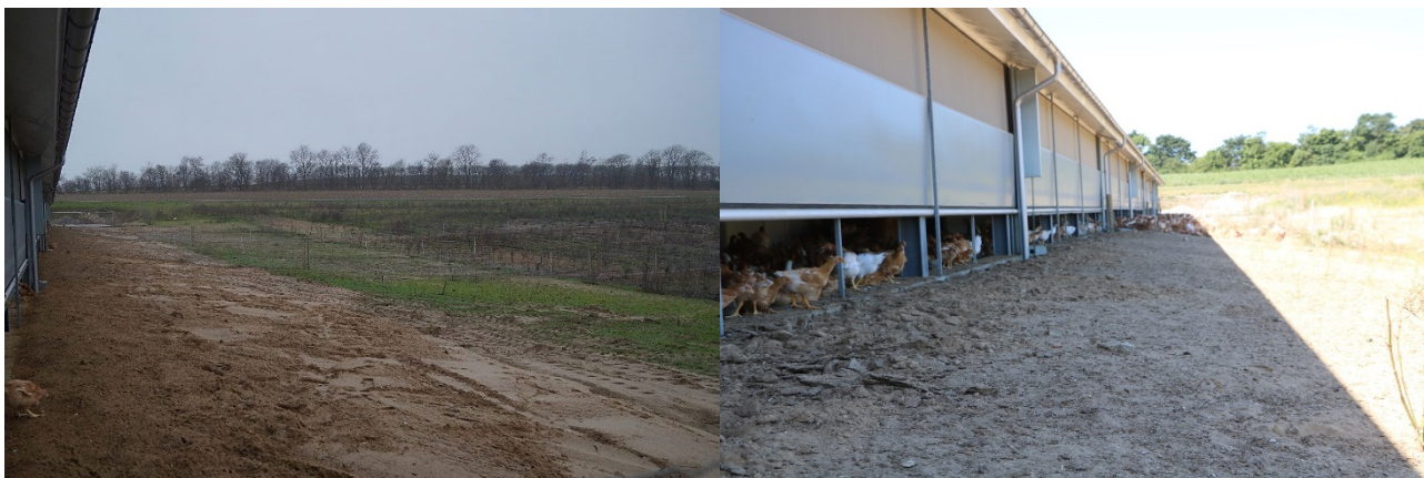
Billede 18. På billederne ses det samme område vinter (venstre) og sommer (højre). Der er valgt en løsning med sand, som bundmateriale foran udgangshullerne fra stalden.
